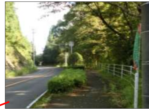
街路樹が多く、暗くて、危険。
