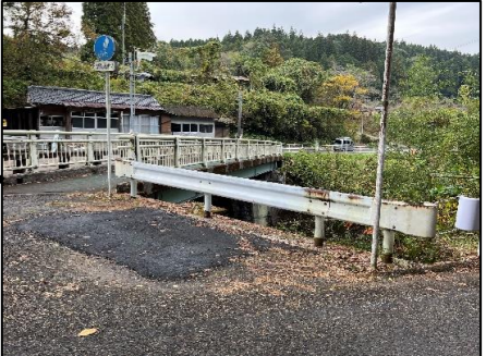
ゴミステーション跡地 ガードレールが 低く転落の危険有
