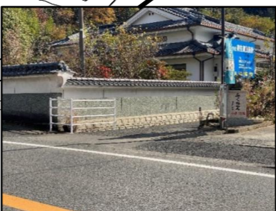
手前はフェンスがあるが 奥はないので転落の危険
