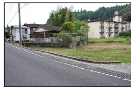
フェンスが無く転落の危険 また、見通しも悪い
