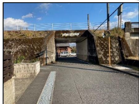
トンネル奥が見通し悪い 白線が見えにくいので危険
