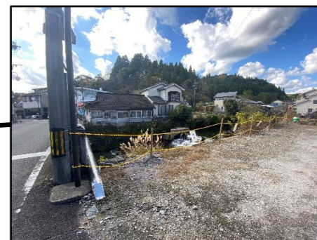
簡易的なバリケードで近づきやすく 転落の危険
