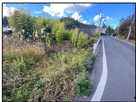
草が生い茂っており ガードレールが無く転落の危険
